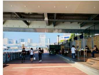
【素通りされていた橋げた空間に滞留を生み出す】
